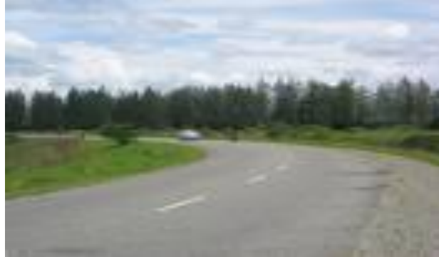
Gambar 2.8. Kondisi Ruas Jalan Strategic
