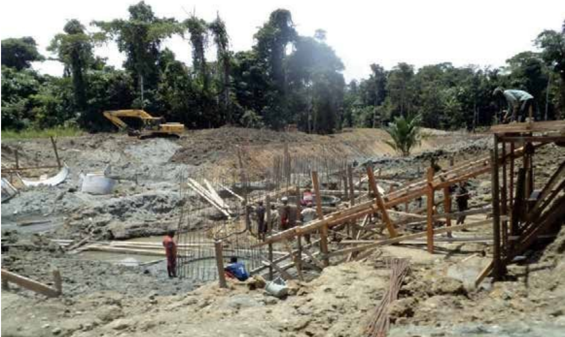
Gambar 2.5. Pembangunan Jalan dan Jembatan di Sarmi (Foto :Alfred Antoh, Oktober 2012)
